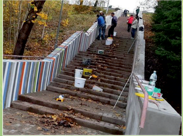
Remont schodów prowadzących na stadion miejski w Białym Borze
