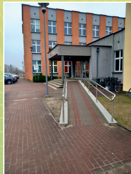
Podjazd dla osób z niepełnosprawnościami przy ZS Nr 1 w Białym Borze
