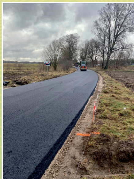
Przebudowa drogi w Grabowie
