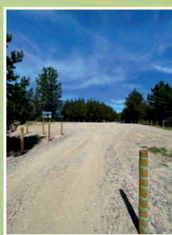
Budowa miejsc postojowych przy Górze Piasku
