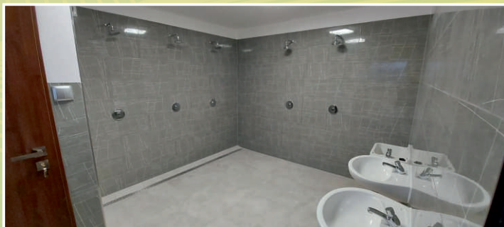
Wyremontowane łazienki na stadionie miejskim
