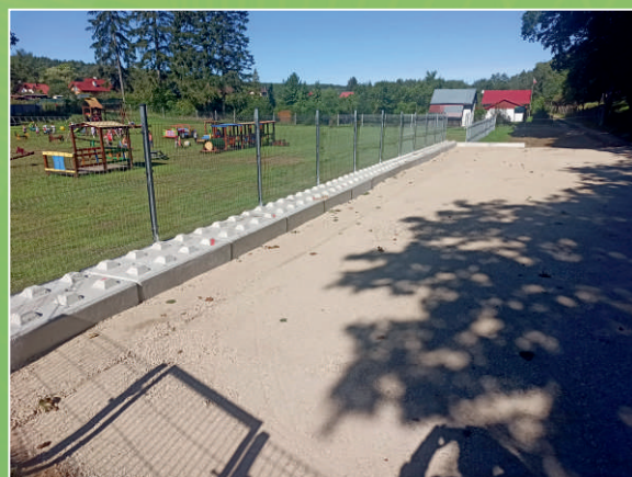
Budowa parkingu przy przedszkolu miejskim w Białym Borze
