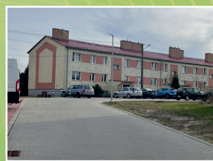
Przebudowa dróg w miejscowości Trzebiele
