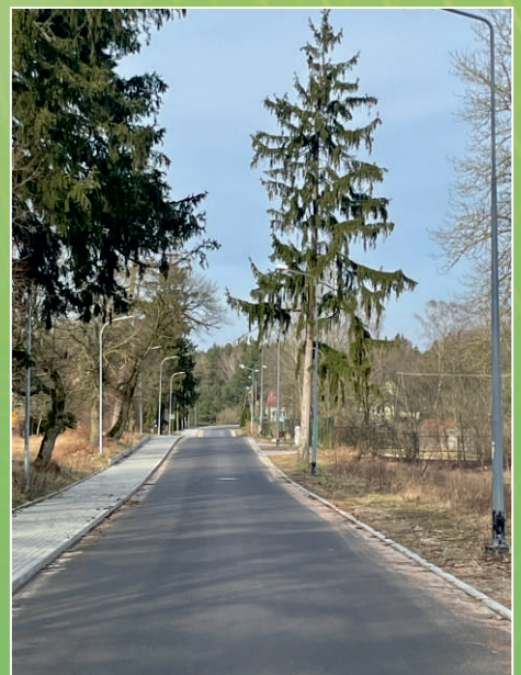
Budowa dróg w Białym Dworze
