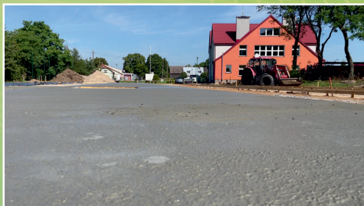
Budowa płyty boiska sportowego przy Szkole Podstawowej w Drzonowie
