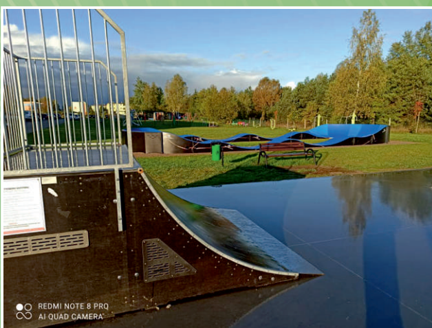
Budowa skateparku oraz pumptracka przy Zespole Szkół Nr 1 w Białym Borze
