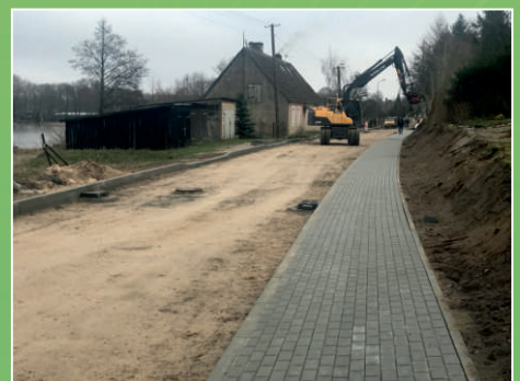
Przebudowa drogi w Stepieniu
