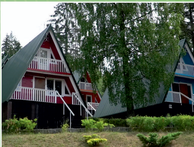
Remont domków letniskowych
