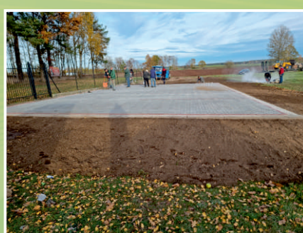
Budowa parkingu przy cmentarzu w Grabowie
