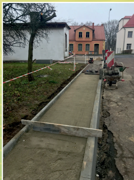
Przebudowa chodnika w Białym Borze ul. Podgórna
