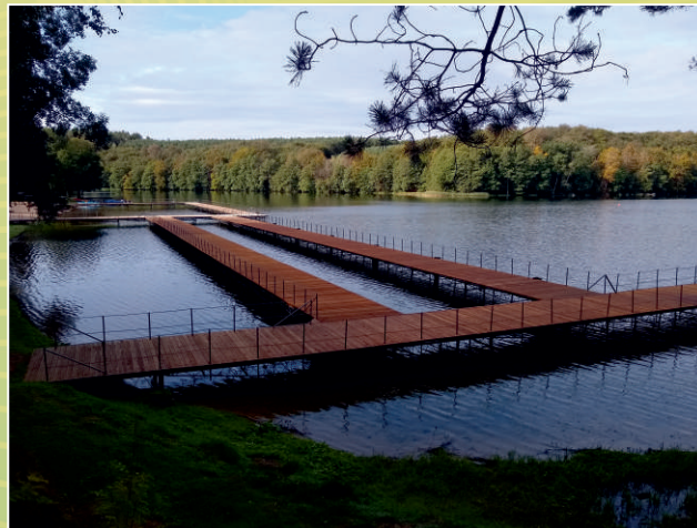
Remont pomostów na jeziorze Łobez
