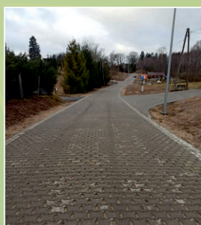
Przebudowa dróg w miejscowości Dołgie
